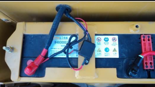
Подключение аккумуляторных батарей
